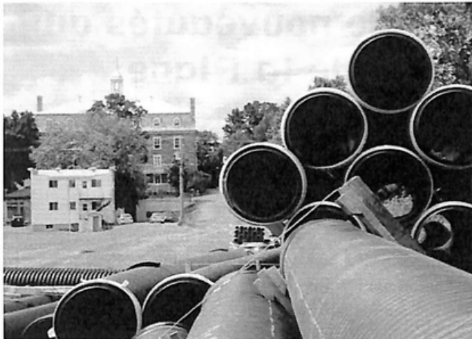
Le matériel nécessaire aux infrastructures souterraines est déjà arrivé sur le nouveau développement domiciliaire.
